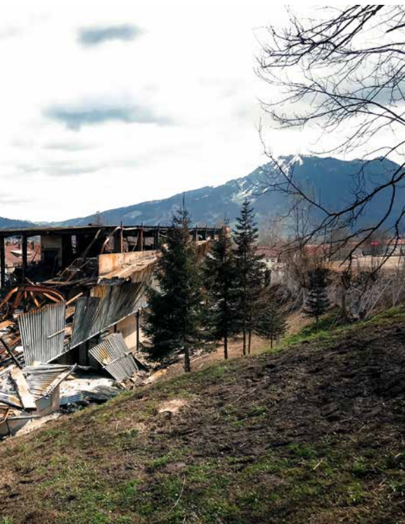
Verpackungsmaschinen komplett zerstört. Ein Abriss der Halle wurde musste aber vollständig gereinigt werden.
